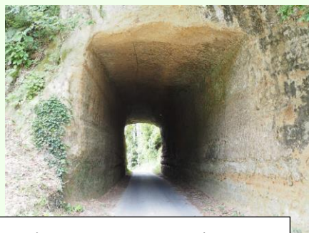
堀跡がリアルに残るトンネル。もちろん道路として現役。
